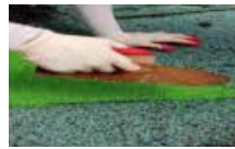
어린이놀이터 바닥재 공사
